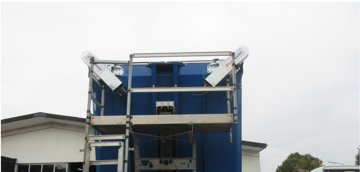
Abb. 10: Antriebe montiert
